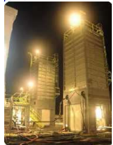
Unitati montate pe platforme deplasabile pentru carbonati si polimer
